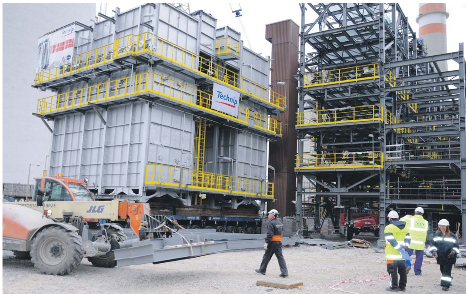
■ Přesun pecí je z celosvětového měřítka logisticky ojedinělý projekt.
