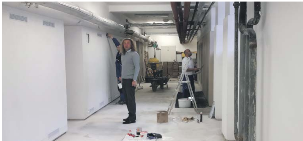
■ Ředitel gymnázia na stavební práci dohlíží osobně.
