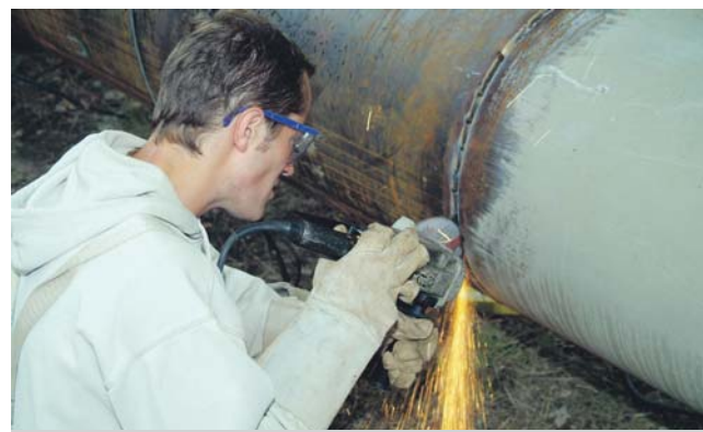
■ Opravy horkovodního potrubí prodlouží odstávku na 2 až 3 týdny.
