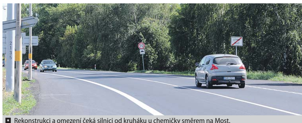
Rekonstrukci a omezení čeká silnici od kruháku u chemičky směrem na Most.
