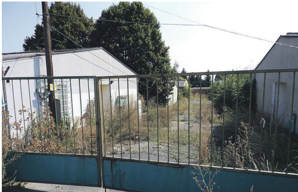
Ubytovna U Bílého sloupu je už roky prázdná. Teď ji město zbourá.
