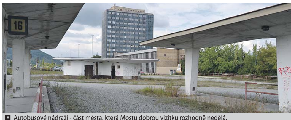
Autobusové nádraží - část města, která Mostu dobrou vizitku rozhodně nedělá.
