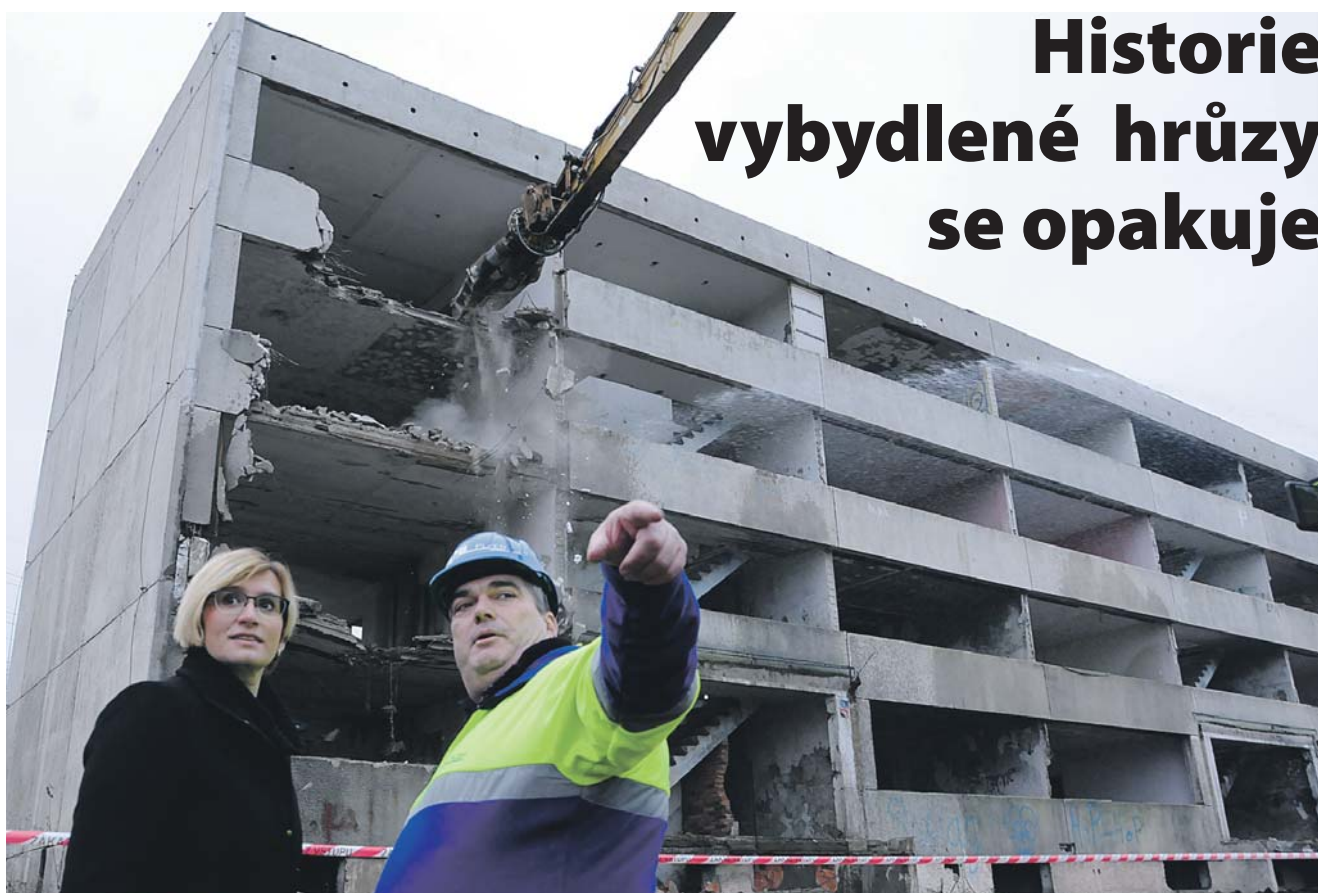
Ministryně Karla Šlechtová zahájila demolici paneláku č. 1 a zdůraznila, že město může žádat o dotace i v příštím roce.
