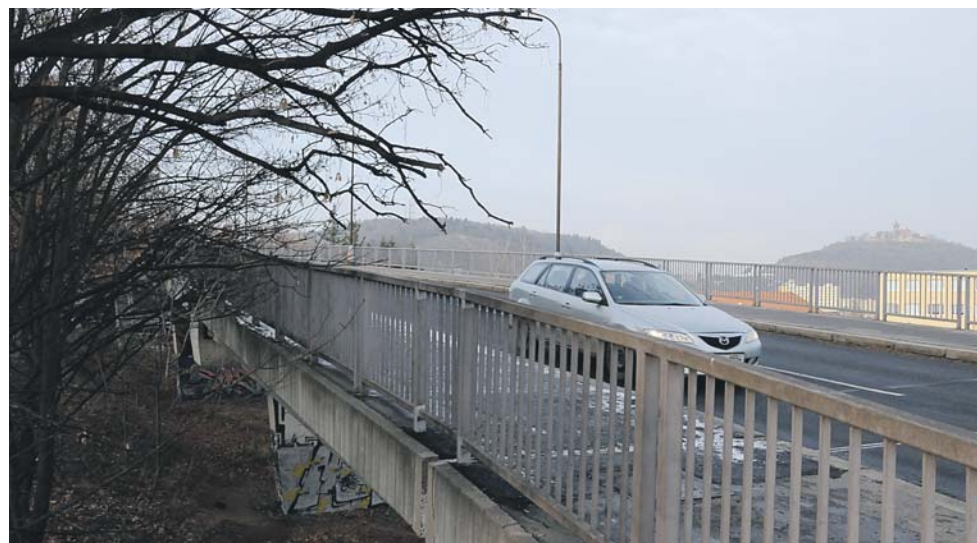
Rekonstrukce mostu potrvá nejméně devět měsíců.
