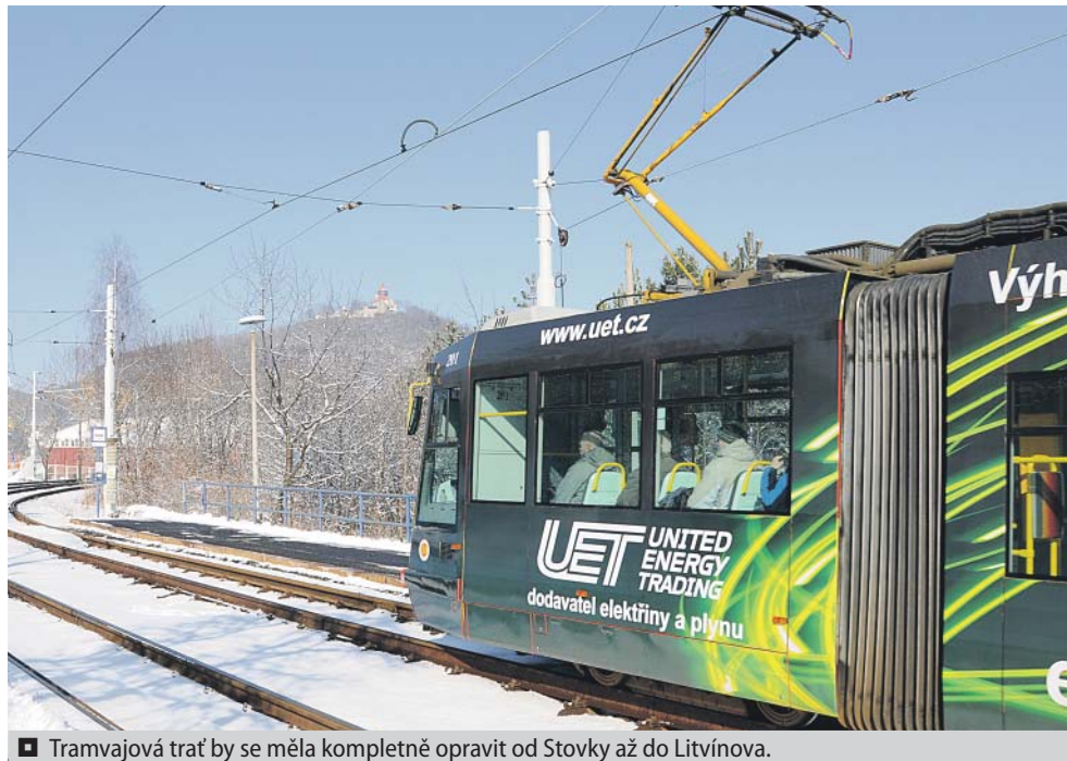
Tramvajová trať by se měla kompletně opravit od Stovky až do Litvínova.
