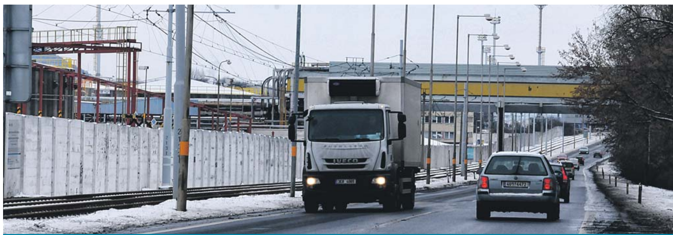
U chemičky zbývá opravit ještě úsek od okružní křižovatky v Záluží ke křižovatce na Kopisty.
