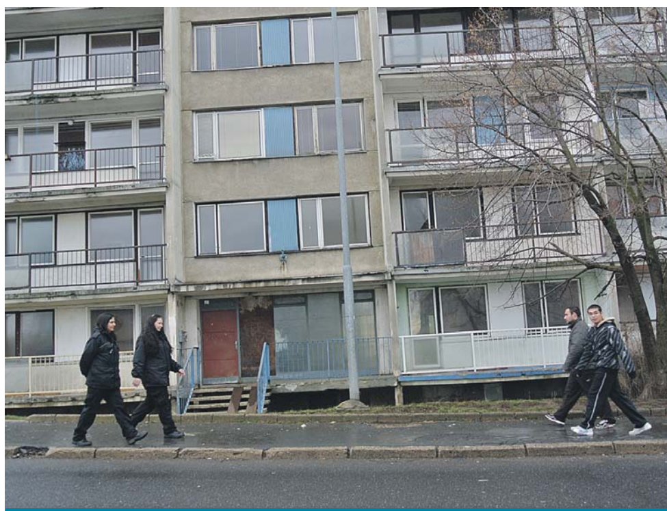
Zdemolovat plánuje Litvínov i některé prázdné domy v Janově.
