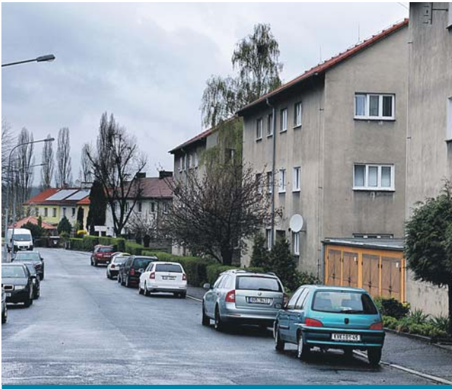
Ulice S. K. Neumanna bude brzy značně rozkopaná.
