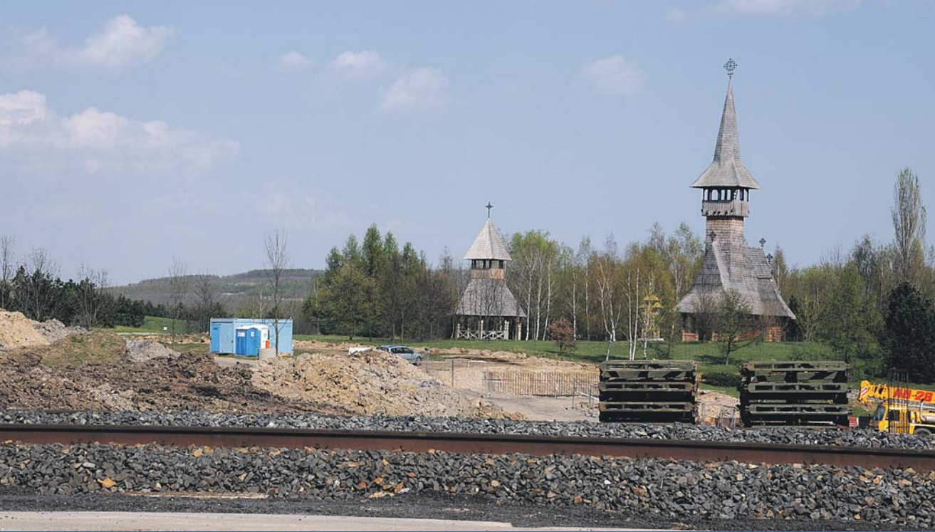
S výstavbou nového přemostění a komunikace kolem mosteckého jezera se „obnažil“ rumunský pravoslavný kostel. Pohled na chátrající stavbu, která nemá zatím jasného vlastníka, je spíše žalostný...
