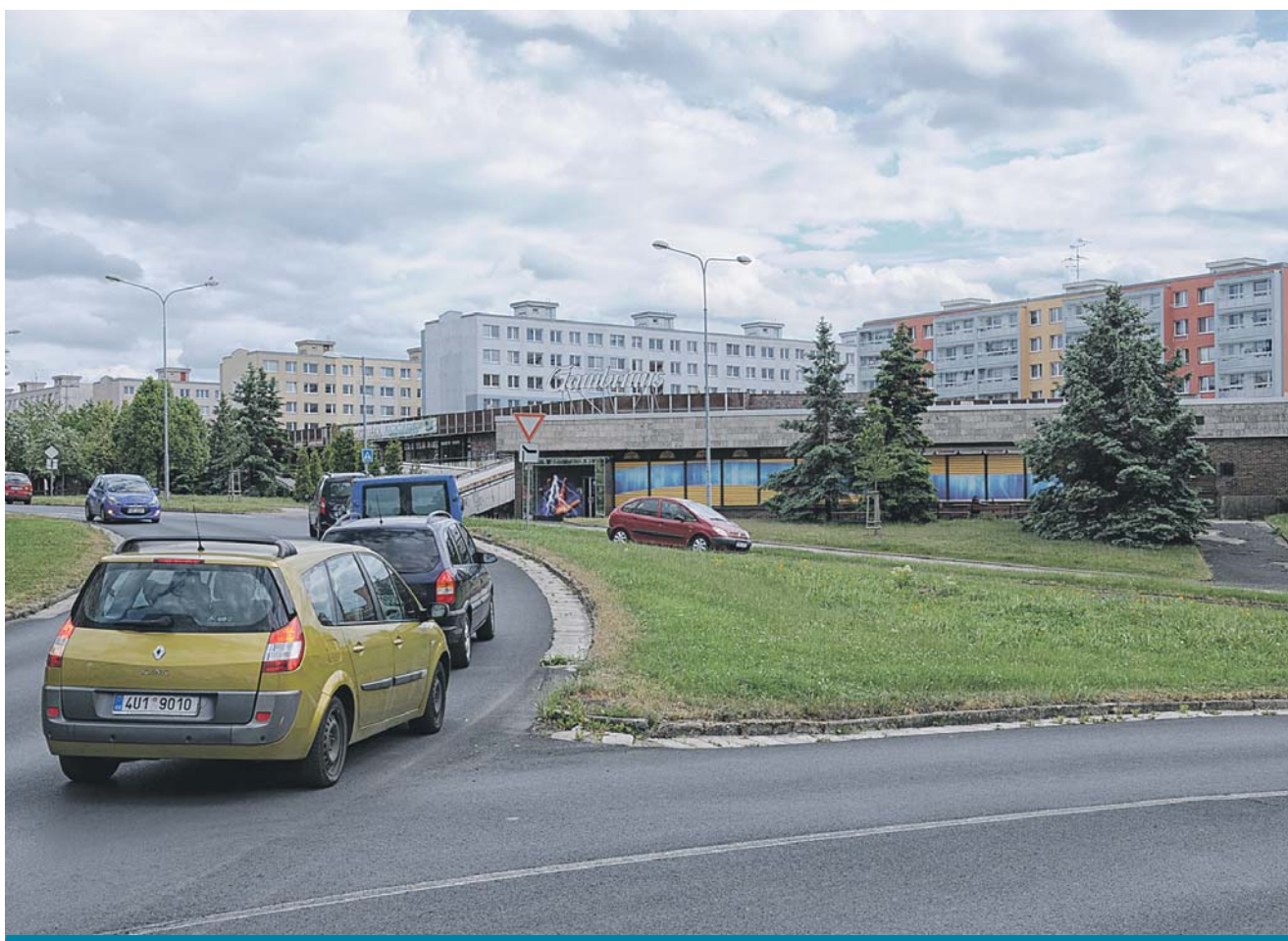
Kruhový objezd nad Aquadromem, který tu chce město vybudovat v roce 2018, bude v pořadí již dvaadvacátý v Mostě.
