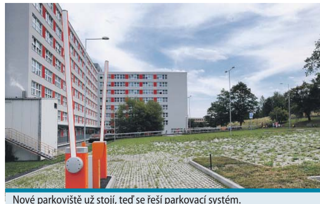
Nové parkoviště už stojí, teď se řeší parkovací systém.
