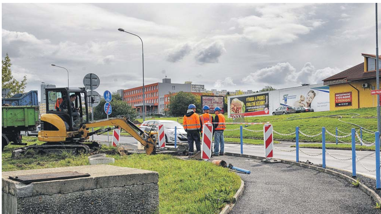
V ulici J. Palacha se začalo s rekonstrukcí vodovodu. Omezení se dotkne i řidičů.
