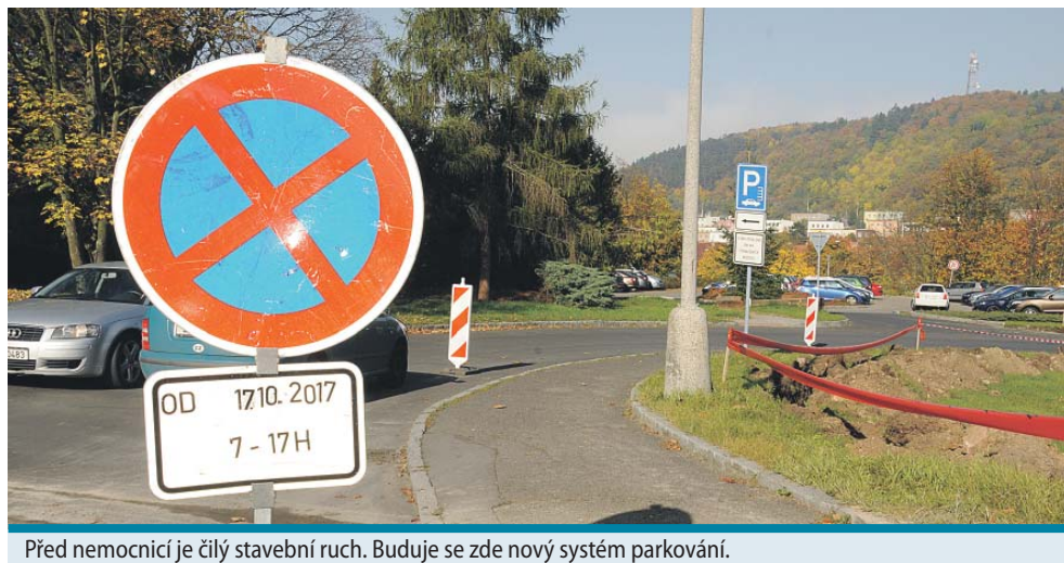
Před nemocnicí je čilý stavební ruch. Buduje se zde nový systém parkování.
