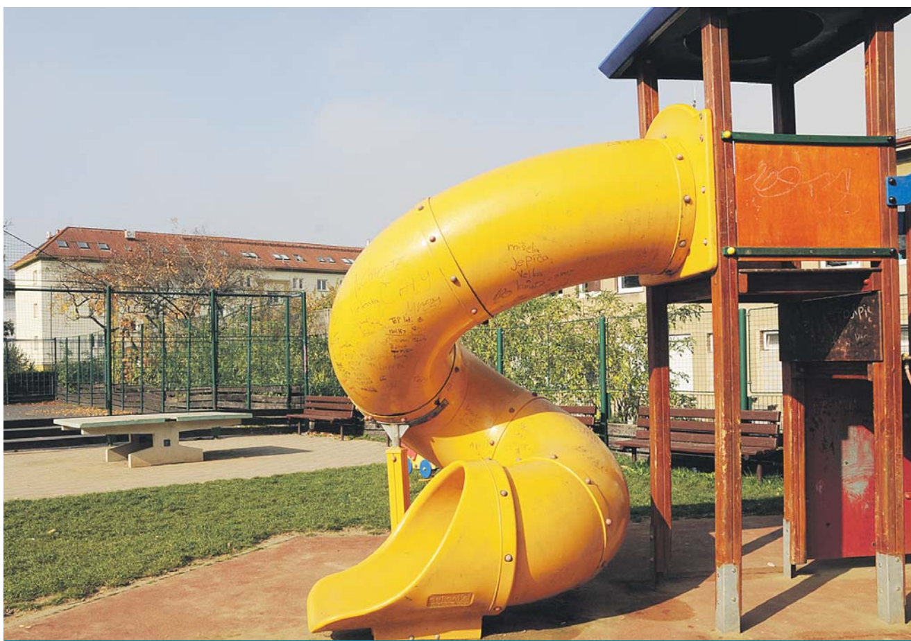
Tradiční obrázek hřiště v ulici Mozarta, které podléhá tlaku vandalů a nepřízřubivých. I v současné době jsou tu poškozené atrakce a zdemolovaný plot v zadní části na míčové hry.
