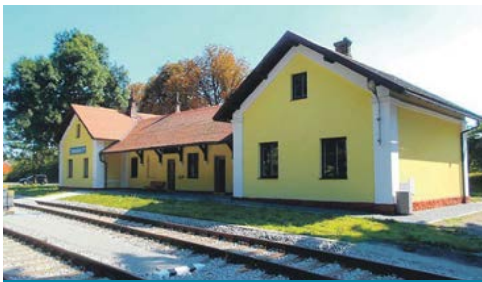
Nádraží v Třebívlicích po opravách...
