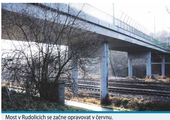
Most v Rudolicích se začne opravovat v červnu.
