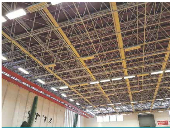
Střešní konstrukce projde rekonstrukcí.
