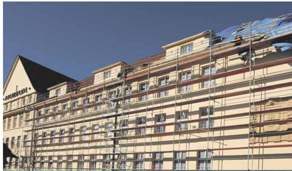
Střecha mosteckého muzea je v rekonstrukci.
