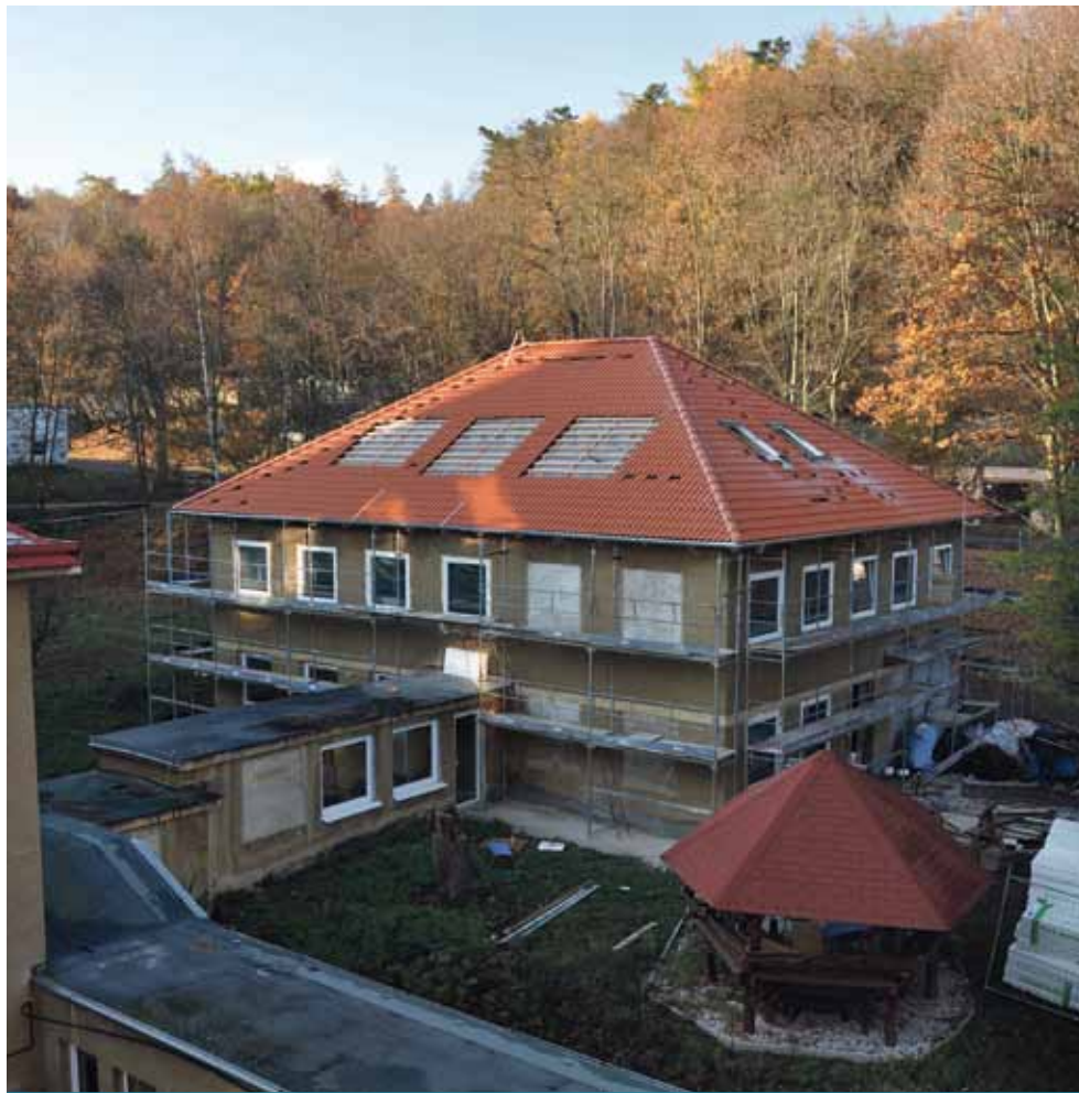
V současné době je hotová nová sedlová střecha, pod kterou vzniknou nové prostory. V pavilonu bude hned několik dílen. Dílna technického vyučování, interaktivní tvořivá dílna, keramická dílna s pecí a dílna technického kreslení s jazykovou laboratoří.
