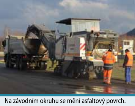
Na závodním okruhu se mění asfaltový povrch.
