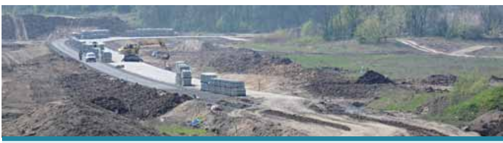
Stavba silnice Most - Mariánské Radčice (duben 2018) v prostoru severozápadních svahů lokality Ležáky.
