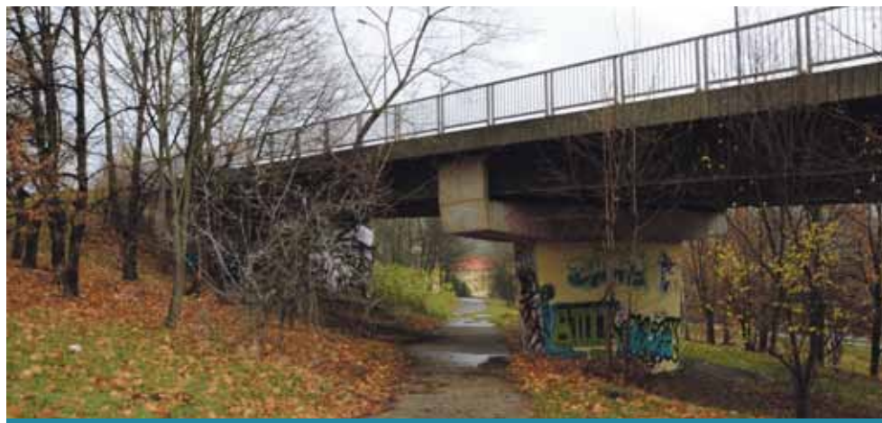
Kvůli opravě mostu u nemocnice čeká Mostečany zhruba roční dopravní omezení. Bude se jednat o jednu z nejnáročnějších investic příštího roku.
