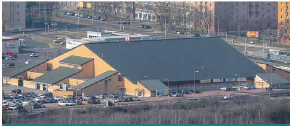
Mostecký zimní stadion zavře své brány. Čekají ho zásadní opravy a modernizace.
