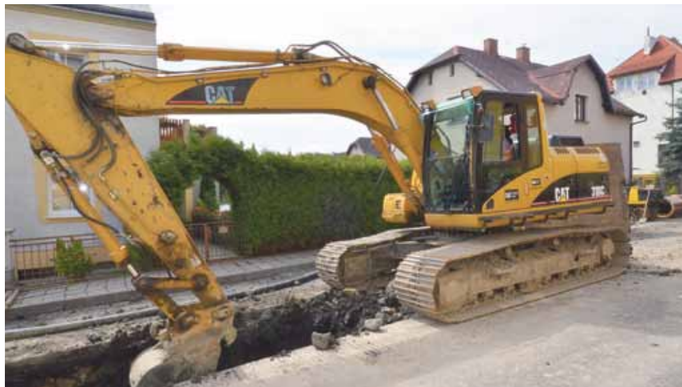
Severočeská vodárenská společnost během léta vymění potrubí na řadě míst v regionu.
