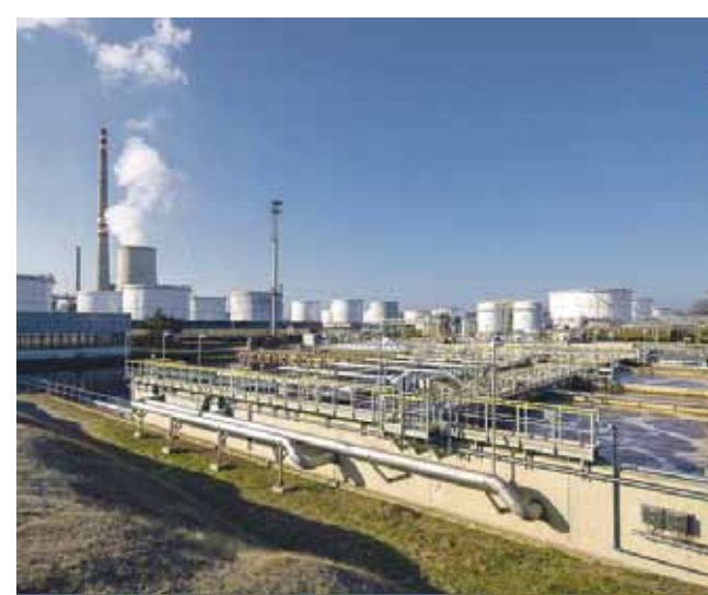
Ve stavbě čistíren odpadních vod jsme na světové špičce.
