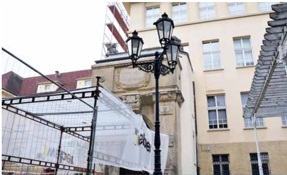
S opravami muzea se začalo už v roce 2015. Postupně se vyměnily rozvody vody a topení. Opravila se kotelná, sociální zařízení a částečně se modernizovala počítačová síť.
