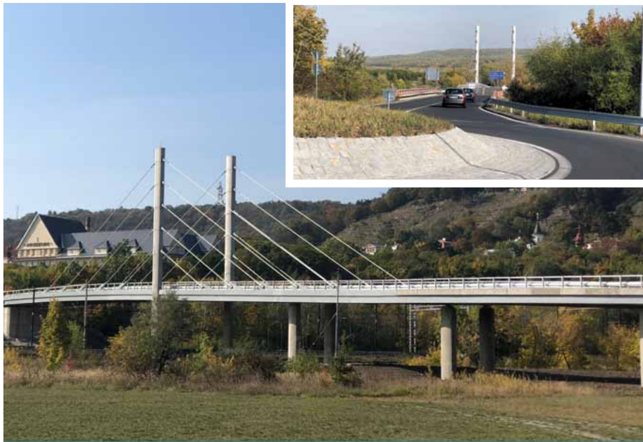
Vybudování nové komunikace kolem jezera hradí stát. Náklady se vyšplhají přibližně na 370 milionů korun.
