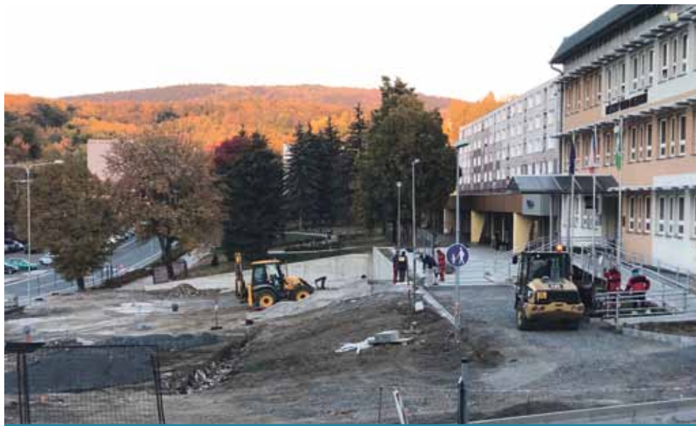
Zatím náměstí v Meziboří připomíná staveniště.
