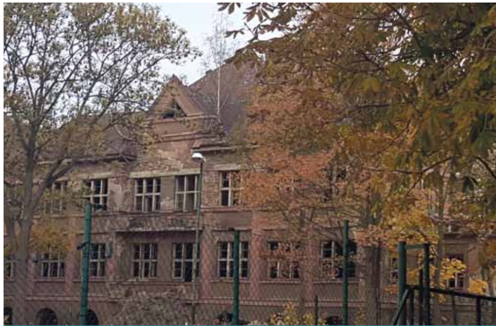
Chátrající objekt v Tylově ulici v roce 2016 město prodalo společnosti Stará lesovna za necelý jeden milión korun. Po přestavbě by tu měly vzniknout prostory pro sociální zařízení komunitního typu.
