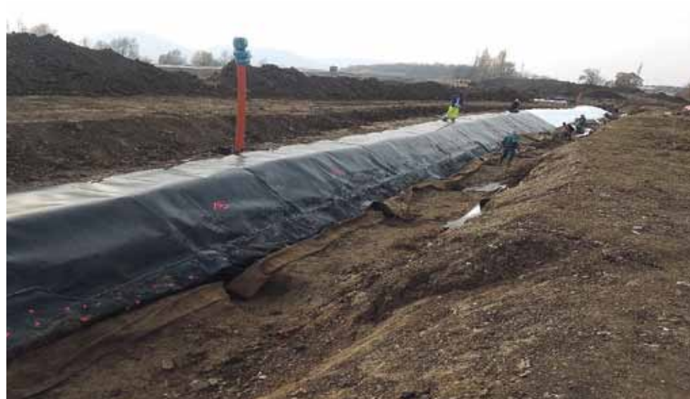
Zbývá dokončit intenzifikaci posledního úseku podzemní těsnicí stěny sloužící k ochraně jezera před průsaky kontaminovaných vod.
