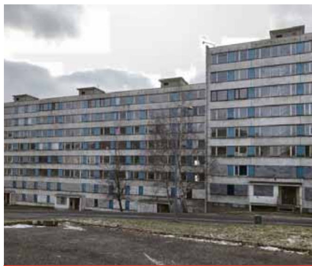
Litvínov má v současné době od CPI v majetku čtyři vybydlené domy, které musí zdemolovat. Dotaci ale zatím žádnou nemá a domy stále stojí. V nabízeném domě mají navíc práva k bytům třetí osoby, a tak město čeká na výmaz těchto práv.
