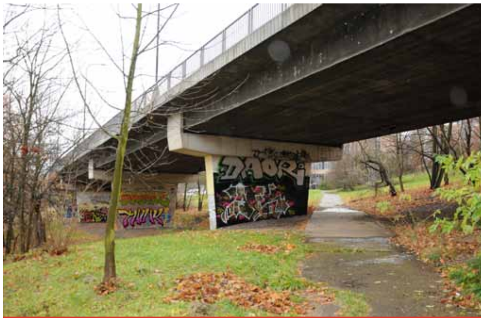
V souvislosti s opravou mostu u nemocnice se lidé musí připravit na dopravní komplikace.
