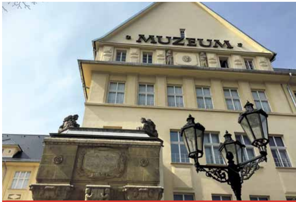
Rekonstrukce střechy na mosteckém muzeu se pravděpodobně o něco zpozdí.
