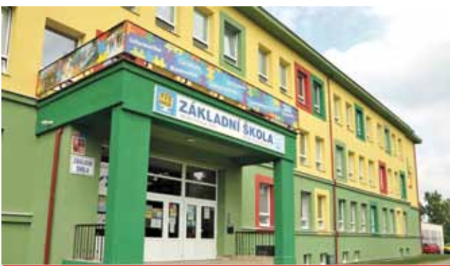
Hodnota nástavby učeben na 7. ZŠ přesáhne 23 milionů korun. Zhruba 16,5 milionu představuje stavební část.
