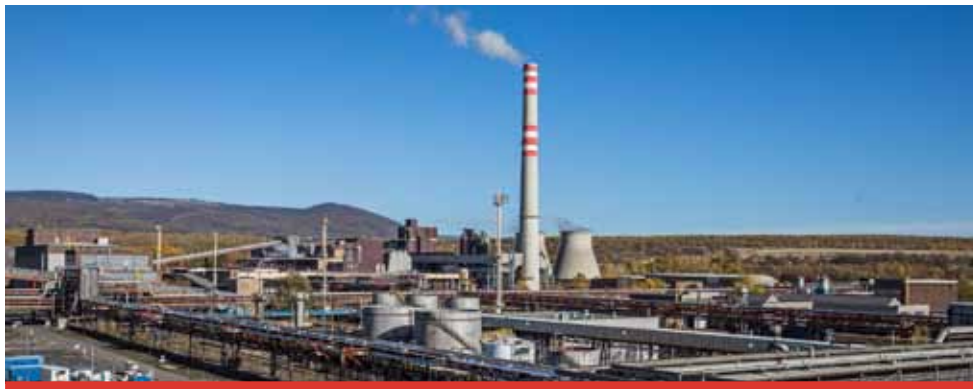
Teplárna T700 prošla v devadesátých letech zásadní rekonstrukcí a modernizací, bylo také postaveno zařízení na odsíření spalin.
