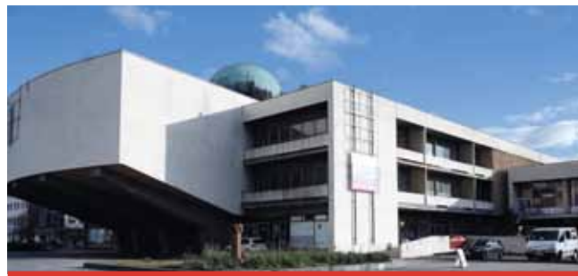
Zastupitelé se zajímali například o rekonstrukci Repre.
