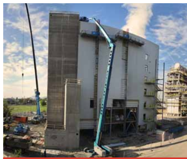
Stavba plynové kotelny Unipetrolu v Litvínově v hodnotě 200 milionů korun.
