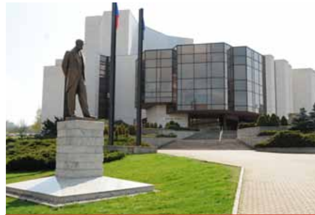
Jako první přijde na řadu střecha městského divadla. Její stav je již neudržitelný.
