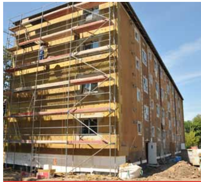
Předpoklad ukončení rekonstrukce bloku 35 je v polovině listopadu. Celkem zde bude 24 nových bytů 2+kk.
