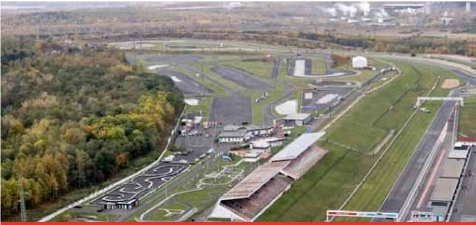
Modernizace závodního okruhu začala před čtyřmi lety a bude pokračovat i v následujícím období. Celkem si vyžádá 100 až 150 milionů korun.
