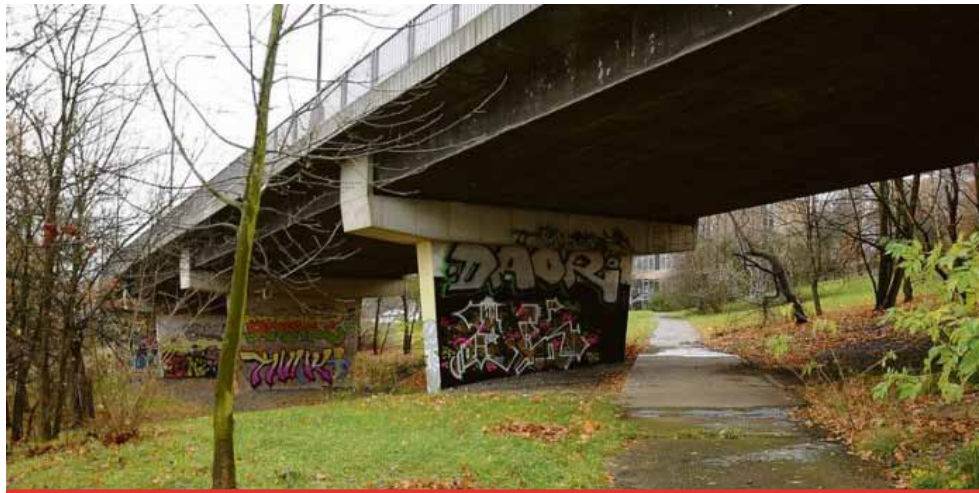
Během opravy mostu se řidiči k nemocnici dostanou pouze ulicí Svážná. Příjezd z ulice J. E. Purkyně se zcela uzavře.
