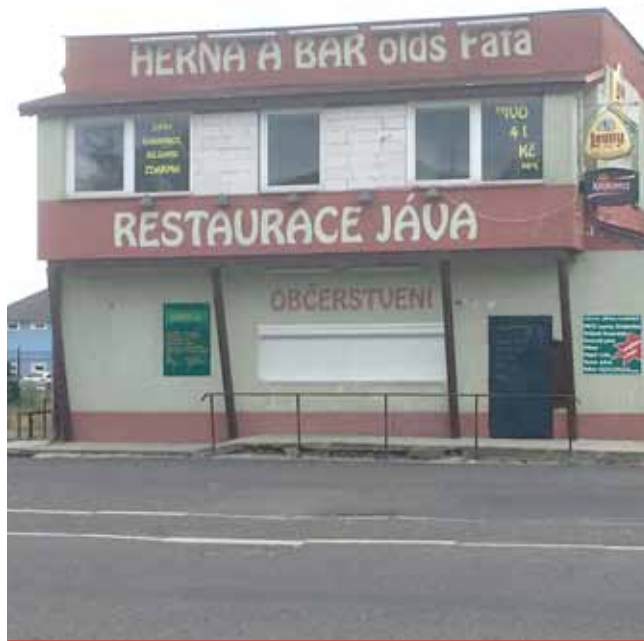
Jednou ze zásadních investic příštího roku je i stavba nového dopravního terminálu na litvínovském nádraží. Stavbě bude muset ustoupit legendární hospoda Jáva.
