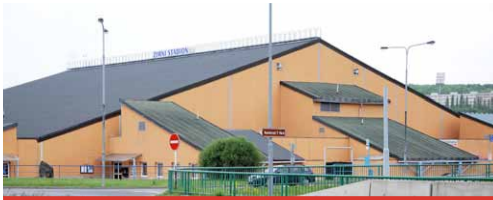
Celkové náklady na rekonstrukci zimního stadionu si vyžádaly přes čtyřicet milionů korun. Město na akci získalo dotaci bezmála sedm milionů korun.
