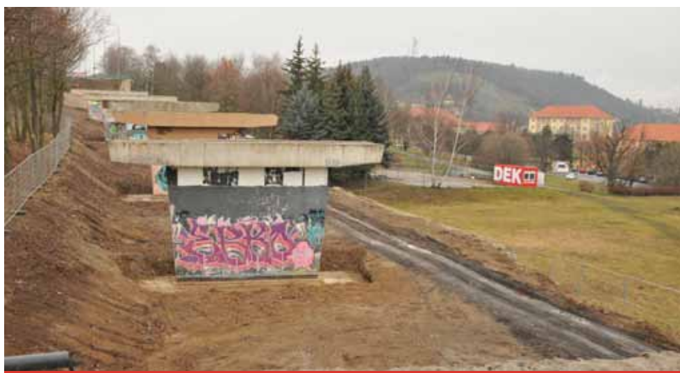
Znovuzprovoznění mostu bychom se měli dočkat pravděpodobně v říjnu.
