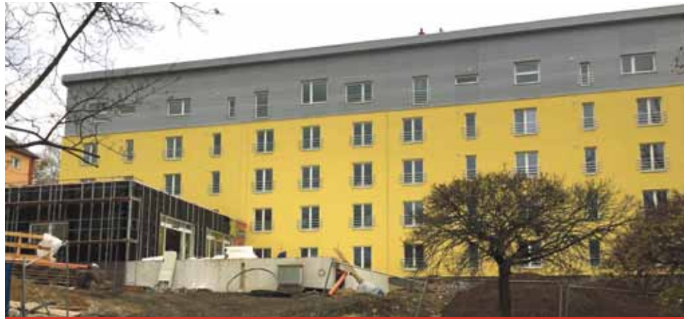
Rekonstrukce bloku 60 v ulici Táboritů, který se mění na Domov Alzheimer, se blíží do finíše.
