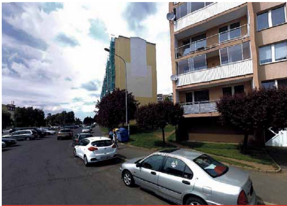
Během letních prázdnin se obyvatelé panelových domů v ulici M. J. Husa mohou těšit na zlepšení podmínek s parkováním.
