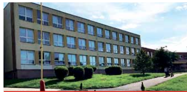
Také mezibořská škola má dostatek hygienických prostředků pro všechny budovy. Za dezinfekce na ruce škola neplatila nic, dostala je darem od několika společností. Ochranné roušky a rukavice získala od města Meziboří. K dispozici má bezdotykové teploměry a u vchodu bezdotykové zásobníky na dezinfekční prostředky.
