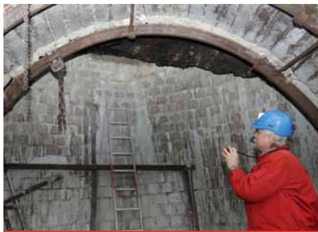
Vstup do dolu uzavřela jedenáct metrů silná hráz.
