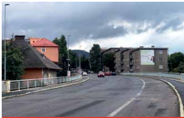
Demolice a následná oprava mostu se blíží.
