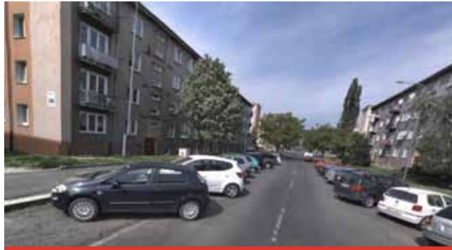
Zásadní stavební úpravy budou probíhat v ulici Mladé Gardy.
