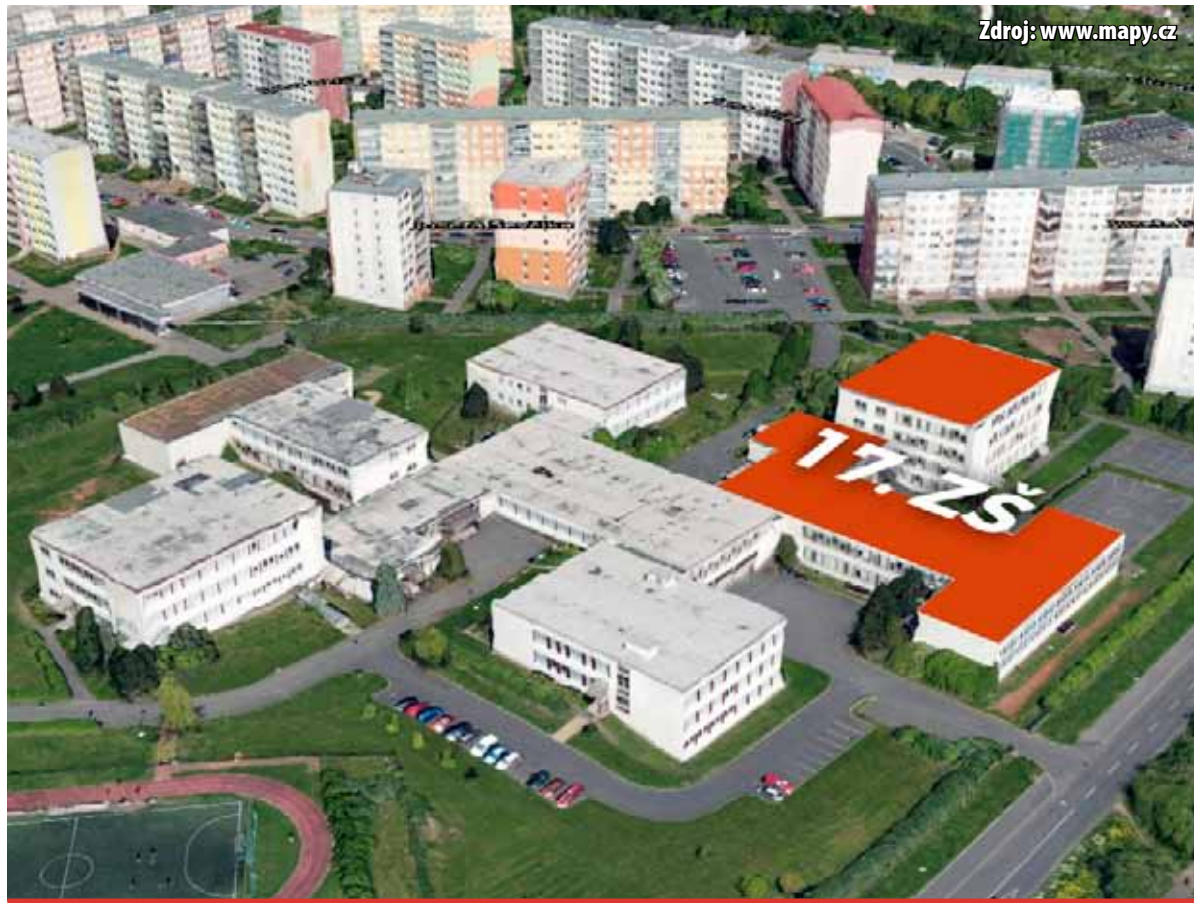
Osud 17. základní školy je definitivně zpečetěn. Město se ji rozhodlo zbourat a chtělo by zde postavit parkovací dům.
