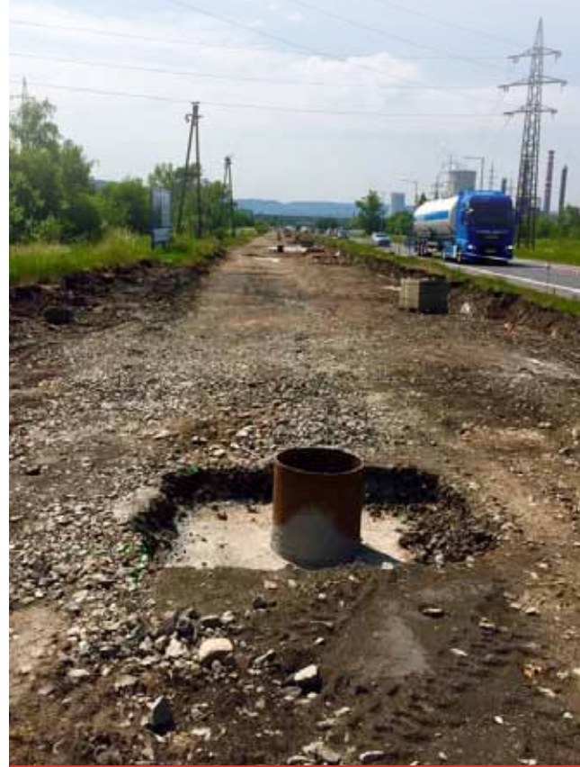
Tramvajová trať vedle hlavní komunikace je kompletně demontovaná. Připomíná staveniště podobné při stavbě dálničních tepen.
