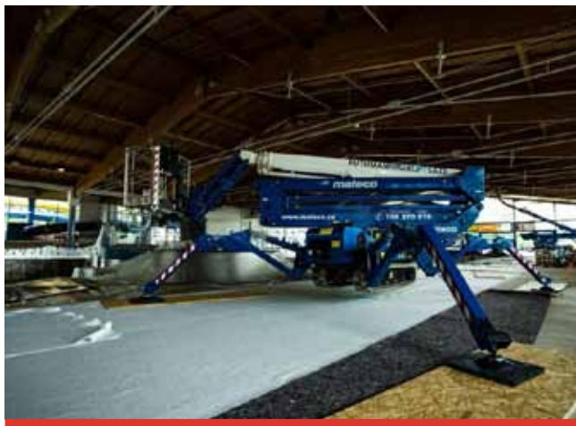
Oprava střešní konstrukce začala v červnu a potrvá potrvá do konce srpna. Jedná o první opravu svého druhu po téměř dvaceti letech fungování Aquadromu v Mostě.
