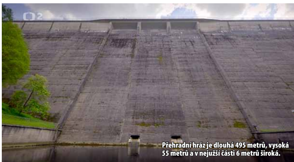
Z betonových stěn trčí stovky železných tyčí. Během stavby se na ně upevňovalo dřevěné bednění. Po dokončení stavby bylo zbytečně drahé ho odstraňovat, a tak zde zůstala spousta bodlin, které přiživují magickou atmosféru.
