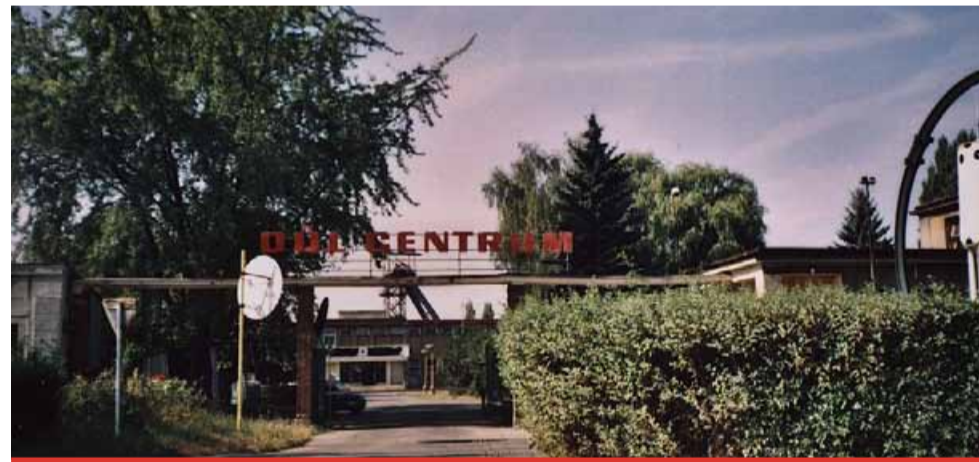
S likvidací Dolu Centrum se začalo 31. března 2016 a trvala přesně rok. Veškeré práce byly ukončeny v březnu 2017.
